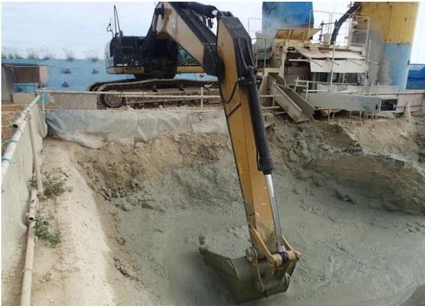
写真-13 建設汚泥の固化状況
